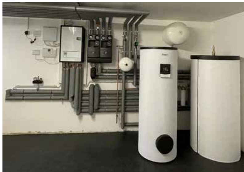
Die Inneneinheit einer modernen Wärmepumpe.
